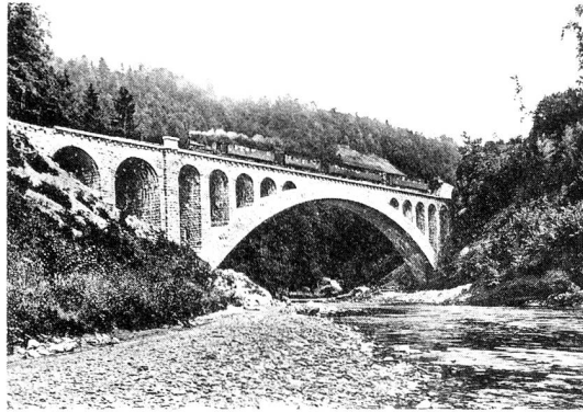
Abb. 6 Der steinerne Eisenbahnviadukt über die Thur bei Krummenau war in den Jahren seiner Entstehung die weitest gespannte Steinbrücke im schweizerischen Eisenbahnbau (63,26 m). Beide Photos aus: Carl Gottlieb Würth, Toggenburg. Zürich 1913.
