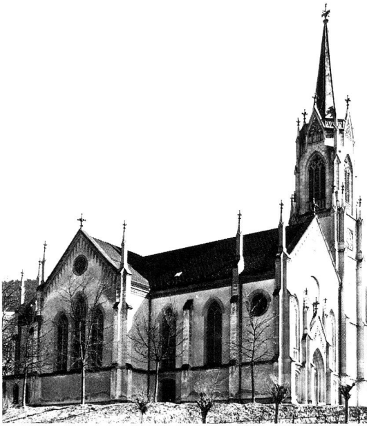
Abb. 15 Ehemalige Paritätische Kirche Lichtensteig. 1866-1868 nach Plänen von Johann Christoph Kunkler, St. Gallen, erbaut, 1968 abgebrochen. Die in Formen englischer Neugotik konzipierte Anlage war neben der St. Laurenzenkirche in St. Gallen der bedeutendste Sakralbau Kunklers. Bemerkenswert war vor allem der reich konstruierte, offene Dachstuhl im Innern der Kirche.
