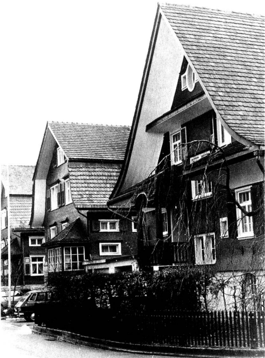
Abb. 22 Haus Näppisuelistrasse Nr. 12 in Wattwil. Musterwohnhaus im Toggenburger Stil. 1911 anlässlich der Gewerbeausstellung von einer «einfachen Gesellschaft für Bauhandwerker» erstellt. Die anschliessenden Mansardendachhäuser entstanden 1911-1912.
