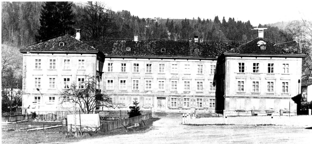
Abb. 4 Mechanische Buntweberei im Sechser an der Grenze zwischen Ebnat-Kappel und Krummennaun. Um 1879/1875 von Josua Looser mit 125 Webstühlen eingerichtet (heute Niederer). Langgestreckter Webereibau auf steil abfallendem Felsen über der Thur. Malerische Wühr- und Transmissionsanlagen versorgen die Fabrik mit Energie aus der Wasserkraft.
