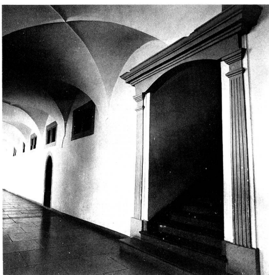
Östlicher Kreuzgangarm mit Front zum Kapitel- saal, bzw. Karlskapelle; Portal zum Treppenhaus von Hieronymus Wirt, um 1628.
