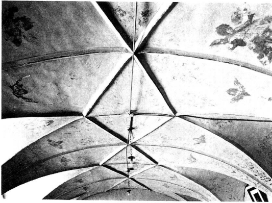
Gewölbe der Karlskapelle im Westflügel mit Stuckgräten von Pietro Andreota, 1629. Die durchschimmernden Malereien von unbekannter Hand.
