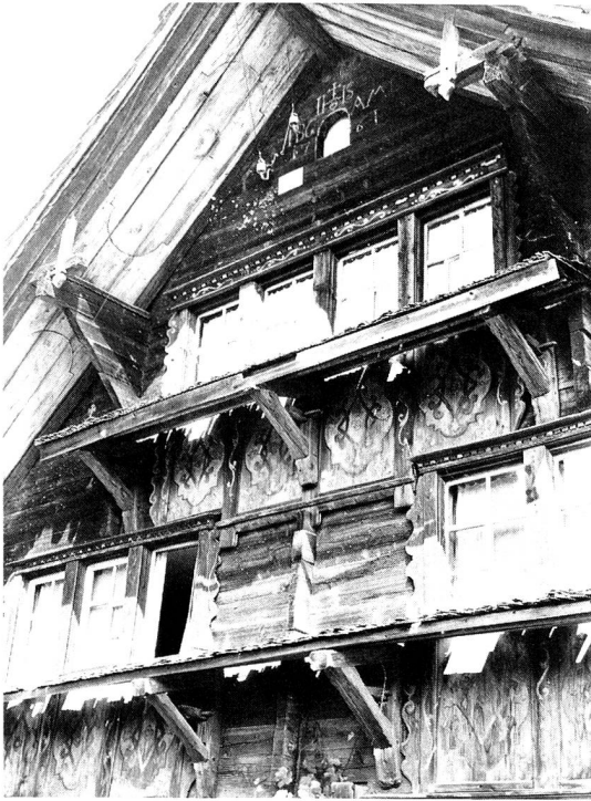
Ober-Bazenheid, Haus Strässle bei der Bahnbrücke, 1761. Ländliche Malereien auf Zugladenverkleidungen vor der Restaurierung.
