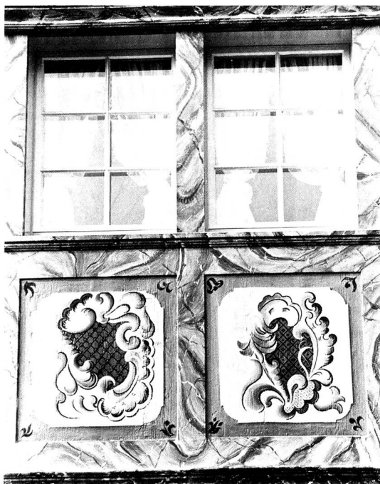
St. Peterzell, «Bädli». Restaurierte Fensterpartie mit Zugladenverkleidung.
