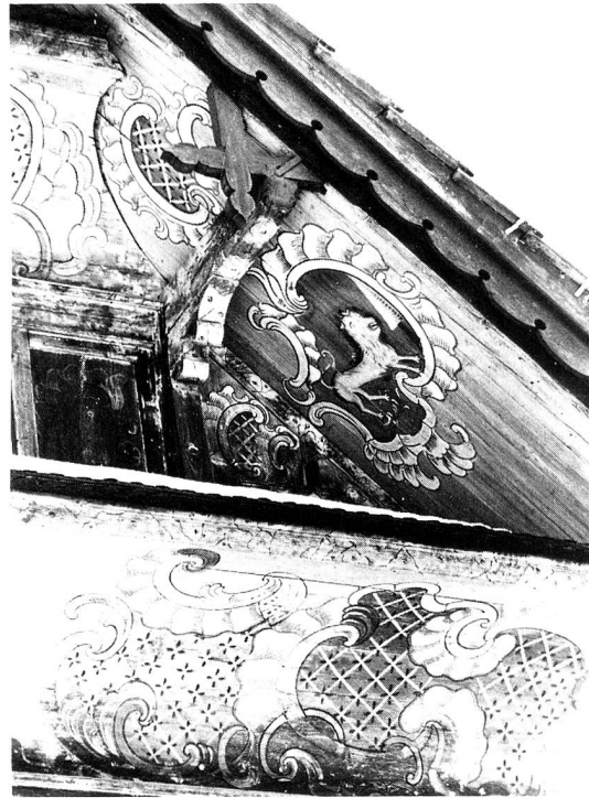
Hemberg, Haus Keller im Bächli, erbaut 1776 von Hans Heinrich Mettler. Bemalte Giebelpartie vor der Restaurierung.
