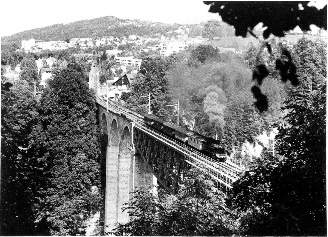
Die Bodensee-Toggenburgbahn ist jung und leistungsfähig geblieben, sie zeigt das durch mustergültige Pflege ihrer Veteranen aus der Bauzeit.
