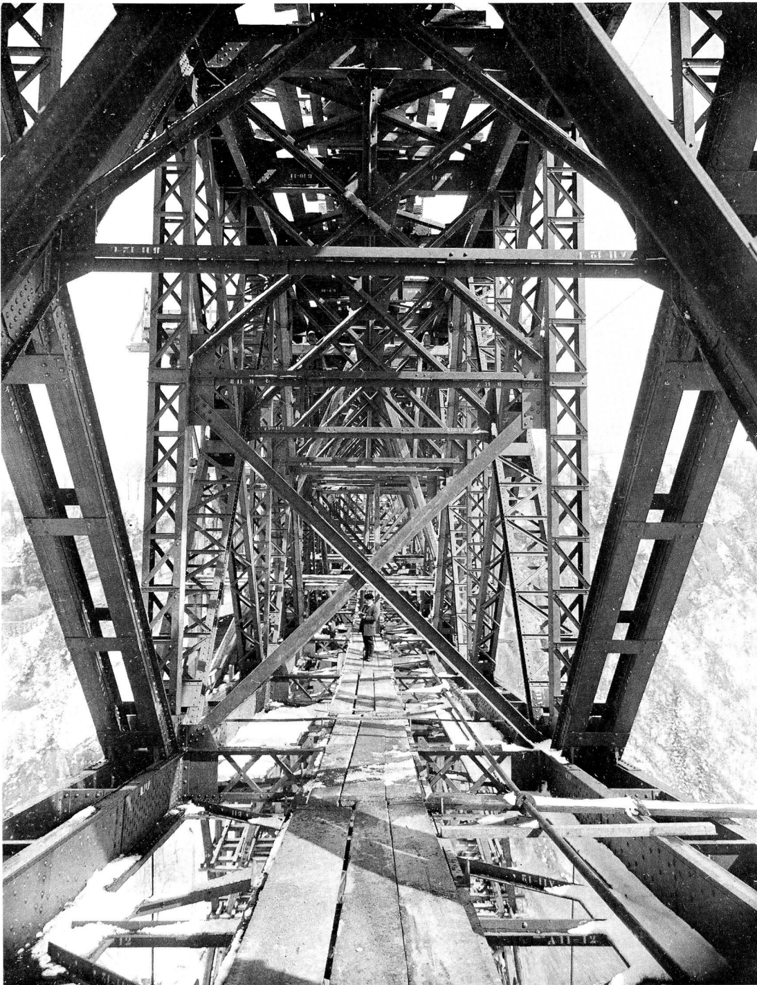
Ungewohnter Durchblick vom Kontrollsteg in den «Bauch» des Halbparabelträgers.
