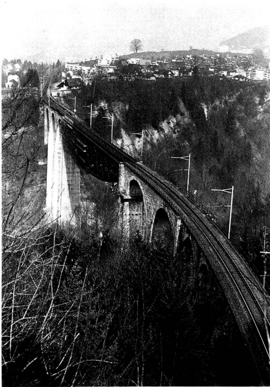
Gut sichtbar sind hier die beiden in Kurven gelegten Anschlusswerke zum Fachwerkträger. Blick Richtung St. Gallen-Haggen.
