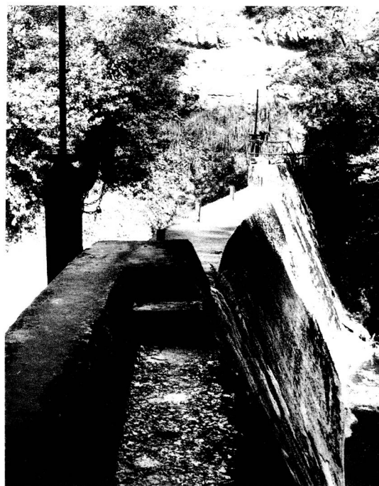
Die Mauer, welche bis 1972 gegen 10 000 m 3 Wasser des Gonzenbachs für die Energieerzeugung aufstaute.
