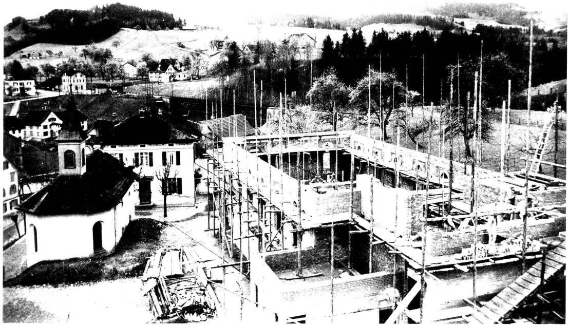
Bau der Kapelle, Einweihung 1933. Daneben die alte Kapelle.
