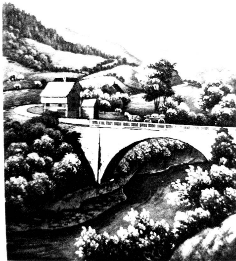
Die neue Thurbrücke in Dietfurt
