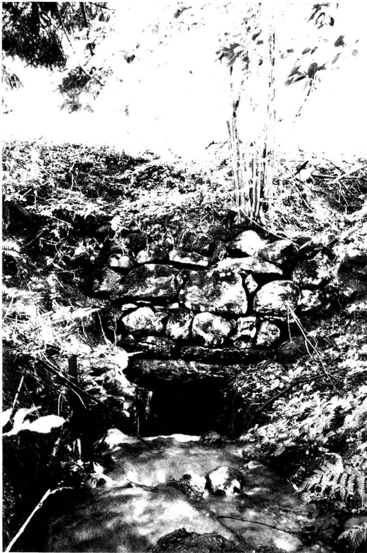
Aus der Postkutschenzeit stammt dieser Bachdurchlass unter der alten Rickenstrasse beim Gallenmösli. Den «Deckel» bilden hier aneinandergeriehte Sandsteinplatten.
