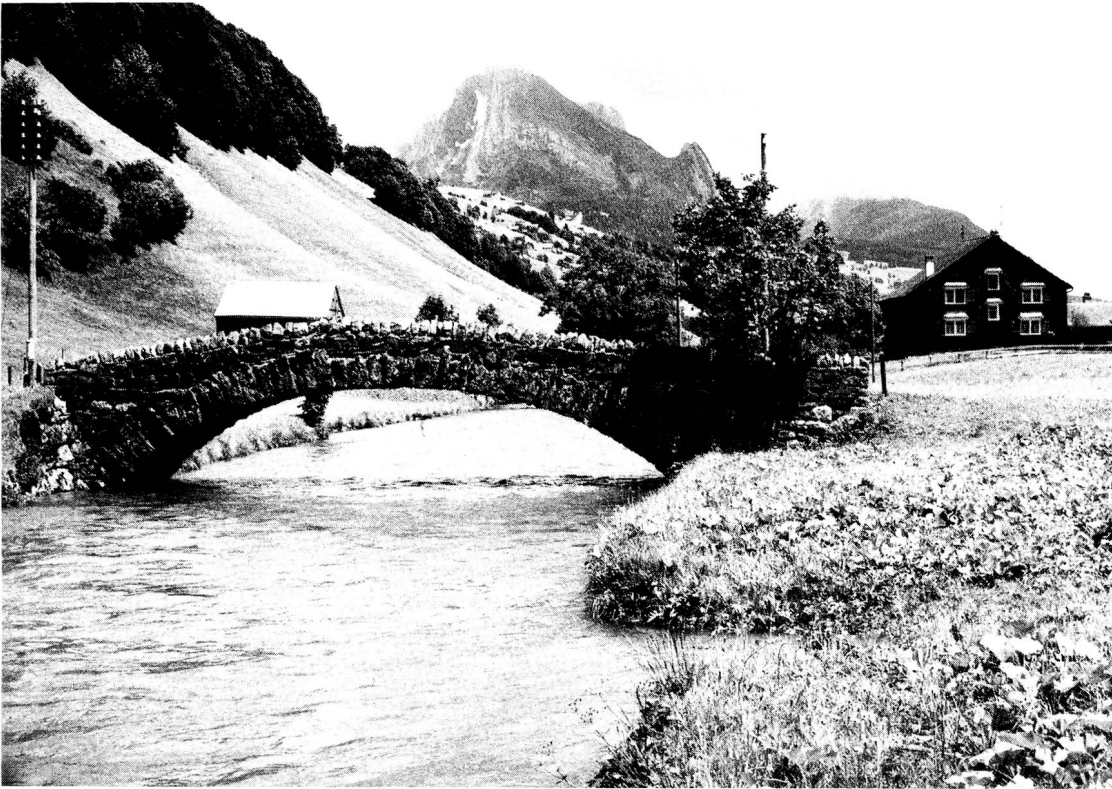
Alt St.Johann, Altersheim. Aus verschiedenen Epochen stammen hier der Steinbogen und die aufgesetzten seitlichen Brüstungen.
