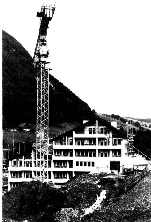
Die rege Bautätigkeit bewirkte in Wildhaus einen günstigen Steuerfuss.
