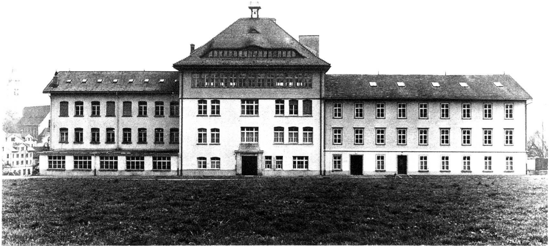
Stickereifabrik Grauer-Frey. Nordflügel mit dem 1908 in Formen des Jugendstils eingefügten Mittelbau von Curjel und Moser. Heutiger Zustand.
