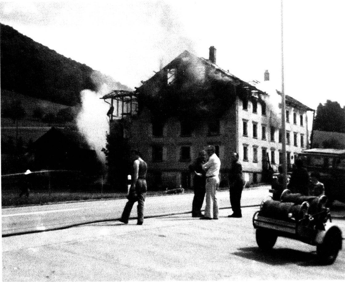
Dietfurt: Kosthaus für Arbeiter der Spinnerei Dietfurt, gebaut 1862 mit 9 Wohnungen, während dem Brand im Juli 1981.
