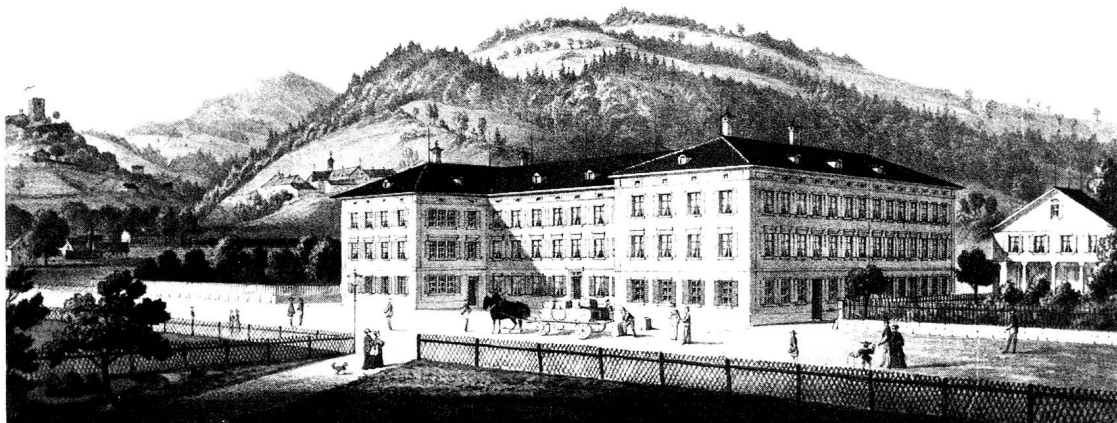
Das Handelshaus an der Unterdorfstrasse, erbaut ca. 1852, diente bis 1917 als Firmenzentrum, seither als Mehrfamilienhaus. Hier wurde die Arbeit der Heimarbeiter koordiniert und abgenommen, ab 1865 waren von hier aus die Webereien in der Rietwies (Wattwil) im Soor (Bütschwil) und die Spinnerei im Necker geleitet worden. (Bild in Privatbesitz)
