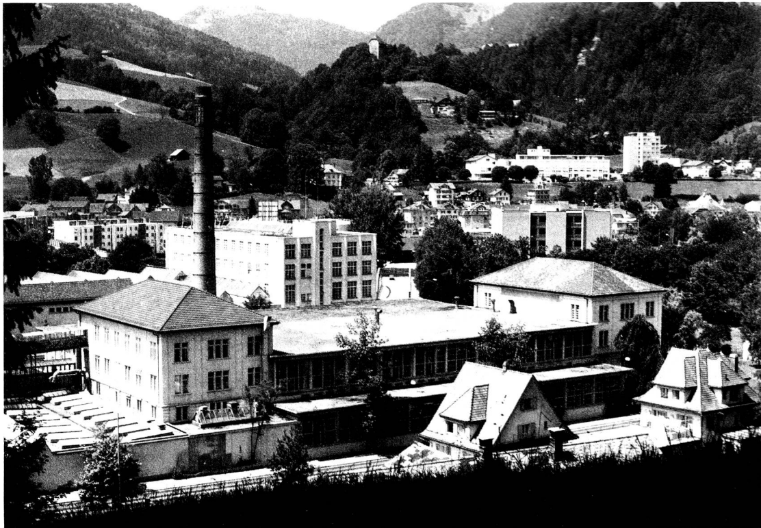
Die Weberei «Raschle» in der Rietwies heute. In den Händen von Heberlein wurde der in Riegelbauweise ausgeführte Mitteltrakt abgebrochen und durch flach bedachte Fabrikhallen ersetzt.
