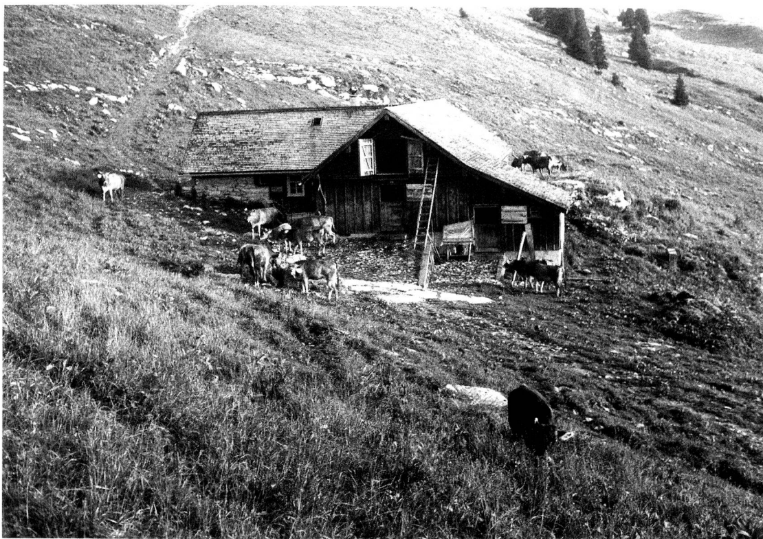
Alpzimmer Gmerk an der Flanke des Selunabhanges. Seine Dachflächen sind noch vollständig mit Holzschindeln eingedeckt. Im Vordergrund Rauhfutter, wie es vom Vieh zu Beginn der Alpzeit angetreten wird.
