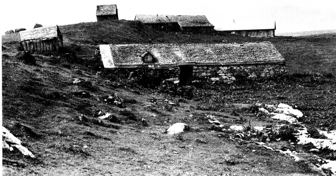
Thurtalerstofel, harmonische Alpstallgruppe mit dem möglicherweise ältesten, in Naturstein gemauerten «Zimmer» im Obertoggenburg.
