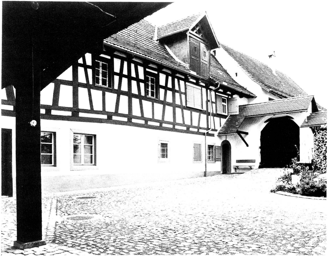
Klausurhof mit Lagerhaus, Pfortengebäude und Einfahrtstor.
