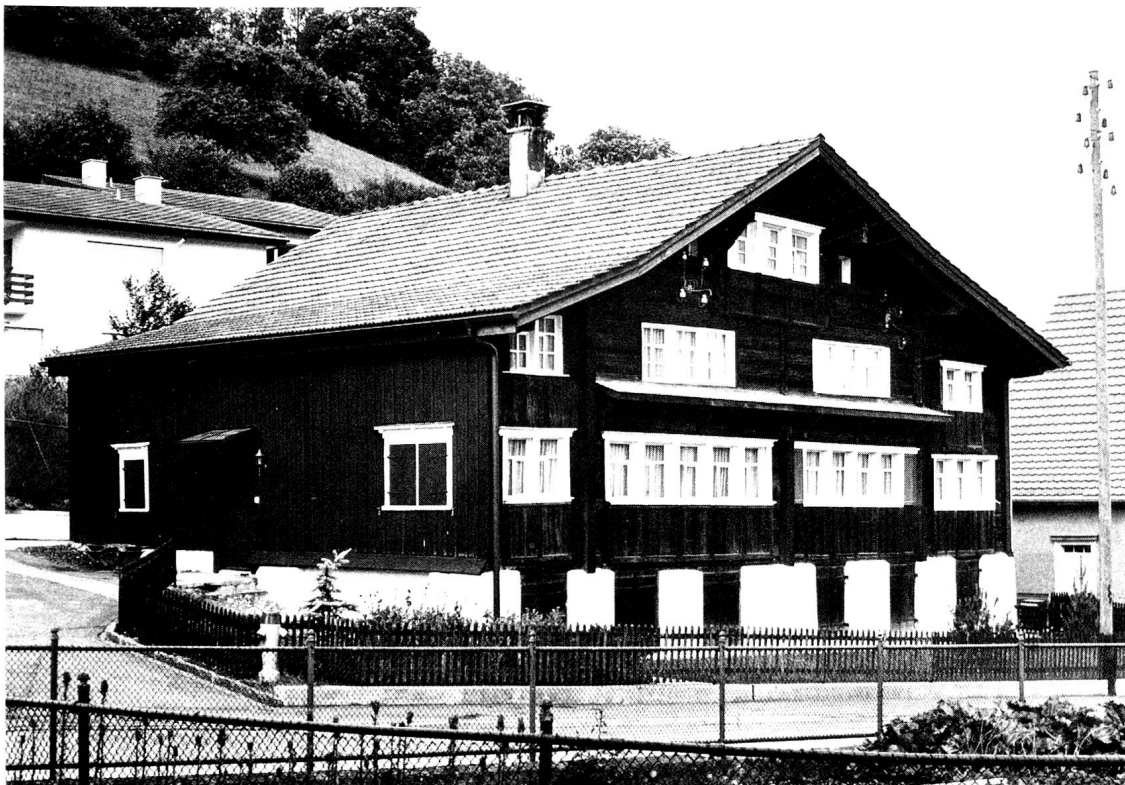
3) Für die grösseren Web- oder Stickmaschinen wurde im 19. Jahrhundert oft – wie bei diesem Wohnhaus im Dorf – der gestrickte Oberbau in die Höhe gehoben. Mit dem steiler stellen des Daches – hier im Mittelteil – gewann man eine zusätzliche Kammer im Firstbereich.
