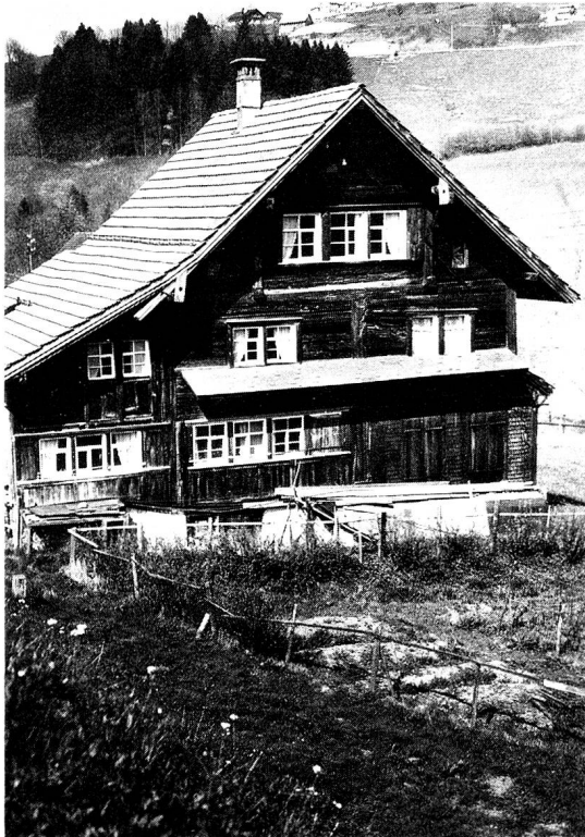
4) Der einzige bekannte und bis heute frei sichtbare Bohlenständerbau der Gemeinde steht im Weiler Rennen, Neckertal. Zum Sticklokal wurde hier die einstige Nebenstube umgebaut, der Wohnraum erfuhr dafür eine Erweiterung im Anbau links.
