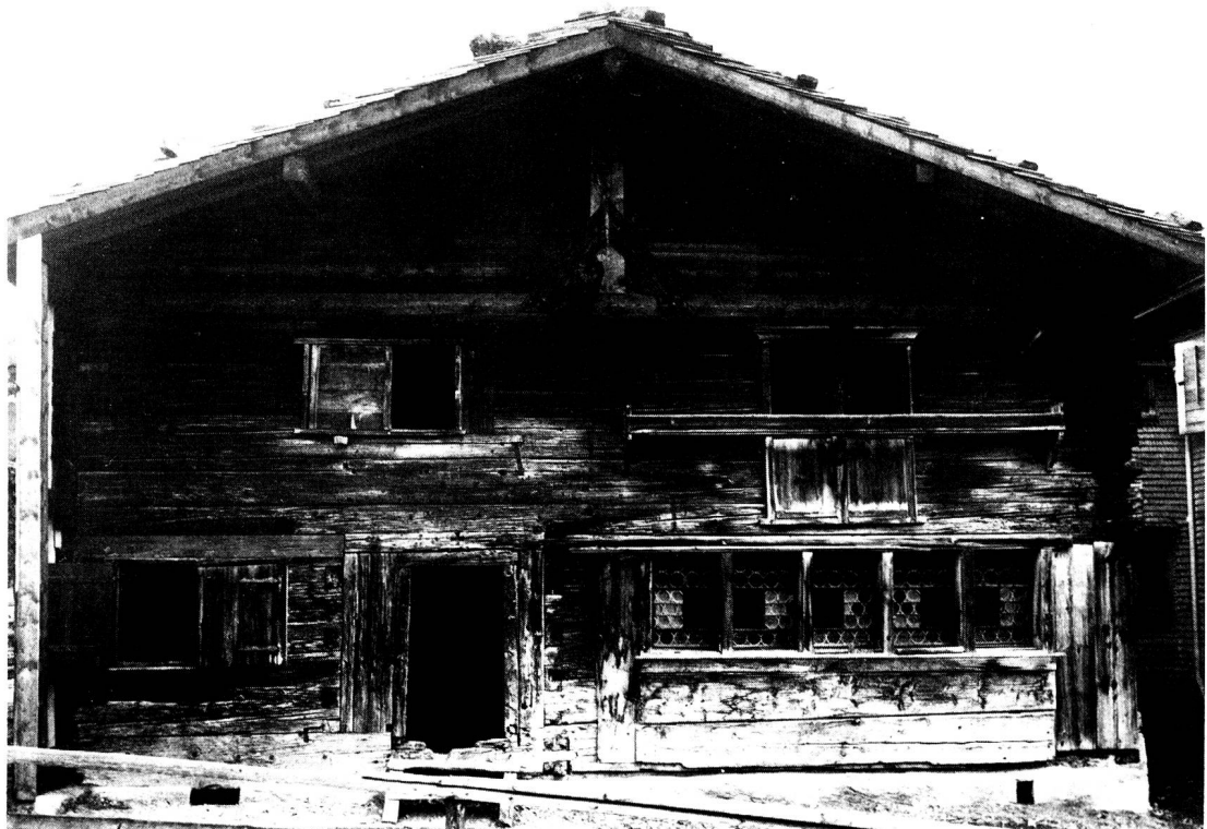
Das Zwingli-Geburtshaus vor der Renovation von 1897. Hier ist deutlich ersichtlich, dass die linke Eckpartie und der Eingang nicht dem Originalbestand entsprechen. Photo in der Zentralbibliothek Zürich.
