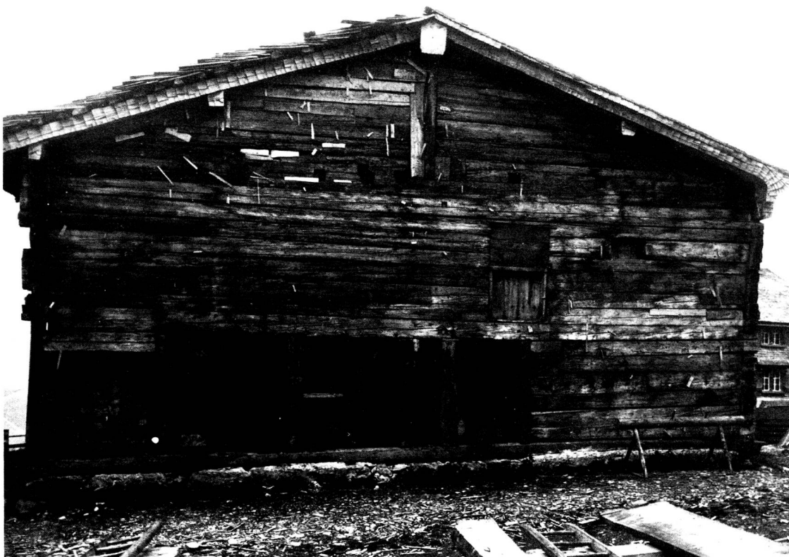
Das Zwingli-Geburtshaus während der Renovation 1897. Die entkleidete Rückseite lässt erkennen, dass hier ein Anbau, wohl ein Stall, angegliedert war. Die linke Eckpartie mit dem neuen Kopfbalken ist sekundär eingefügt. Photo in der Zentralbibliothek Zürich.
