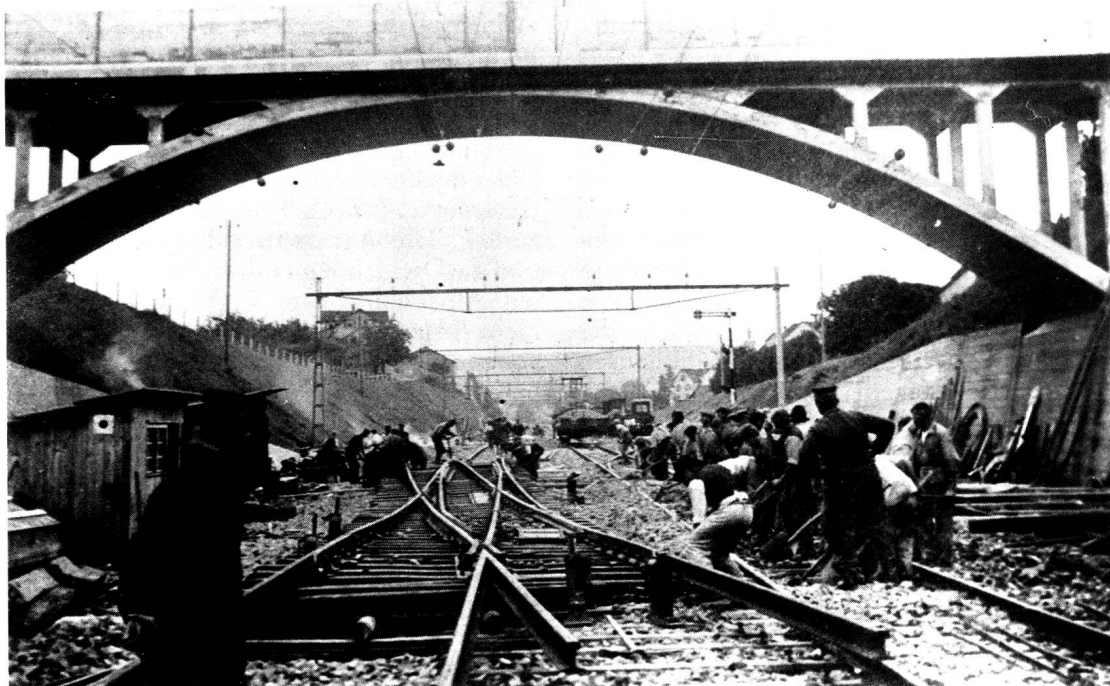
Geleiseumbau anlässlich Einbau Doppelpur mit der neuen Krankenhausbrücke.
