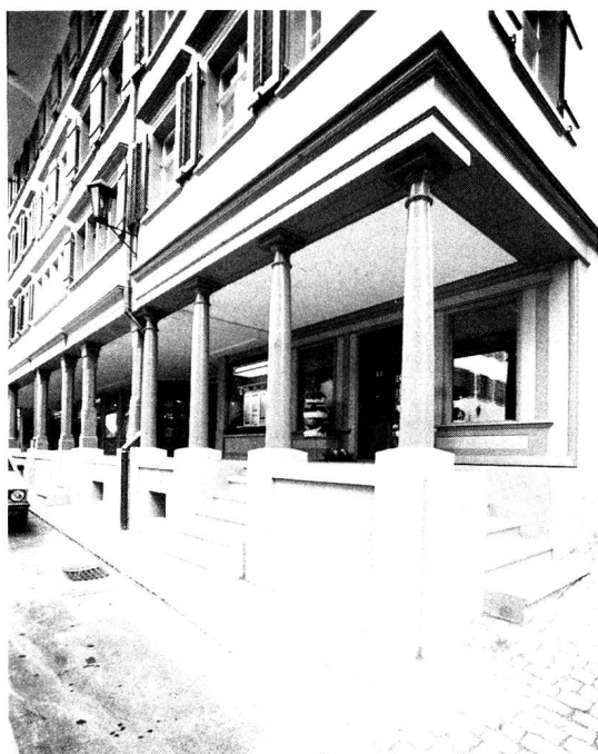
Die Arkaden nach dem Wiederaufbau 1986. Die alten Säulen konnten nach gründlicher Überholung wieder verwendet werden; Ausführung des Arkadenbodens und der Treppen in Sandstein.
