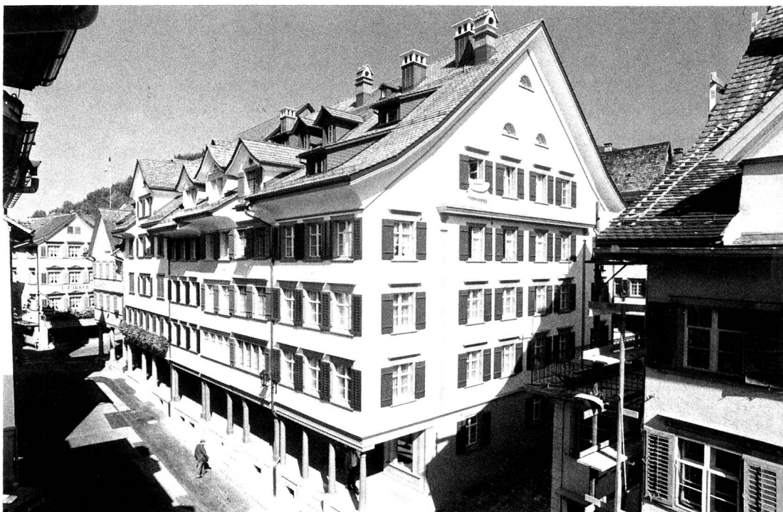
Südliches Eckhaus nach dem Wiederaufbau, 1985/86
