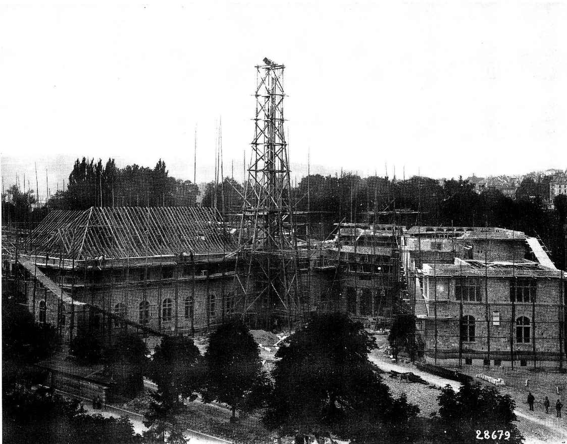
Das Schweizerische Landesmuseum in Zürich während der Bauarbeiten im Jahre 1897. Der Tuffstein kam aus Libingen und wurde von der Firma Steiger und Kuhn in Flawil geliefert. – Foto Schweiz. Landesmuseum Nr. 28679.
