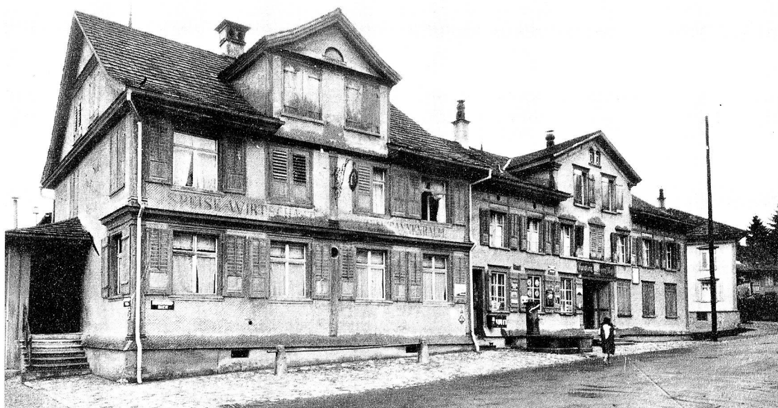
Beidseits der Speisewirtschaft zum «Tannenbaum» und auf der Landstrasse strömte das Hochwasser vorbei.
