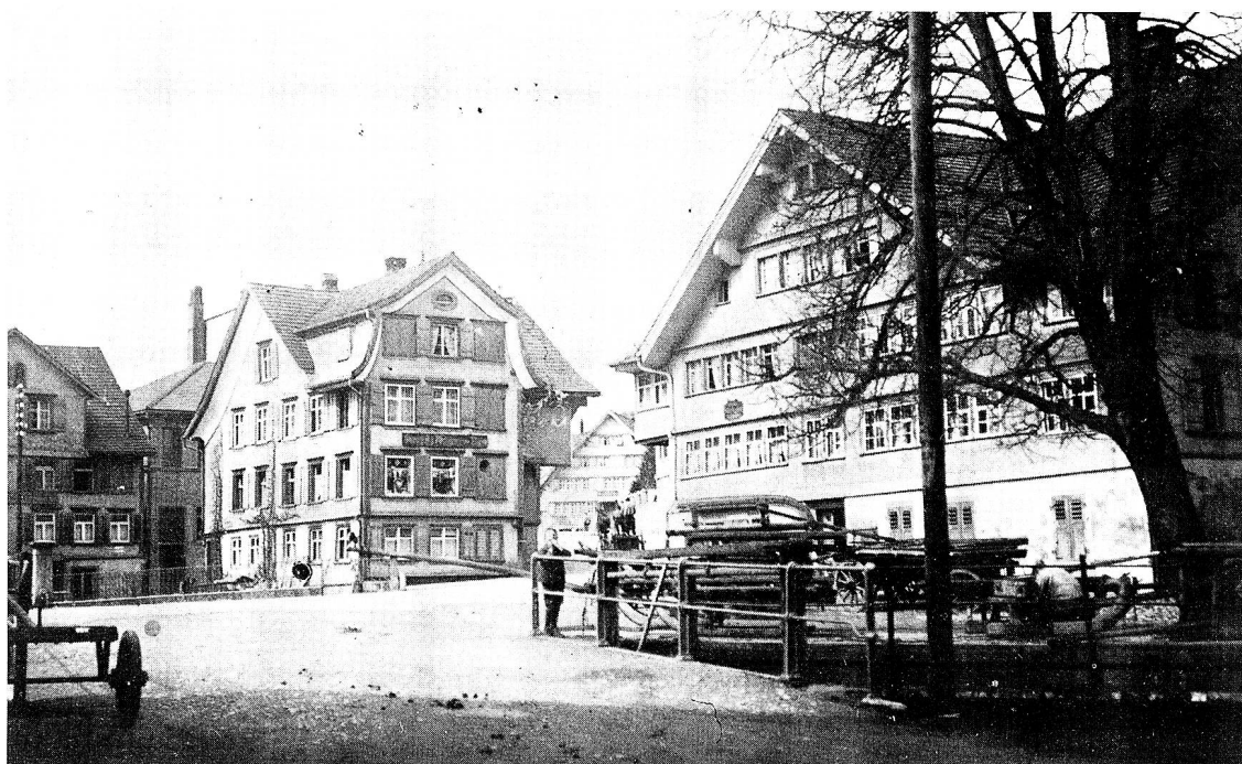
An der Einmündung Botsbergerbach in den Goldbach hat das über die Ufer tretende Wasser die umliegenden Häuser gefährdet. In der Bildmitte der 1963 abgebrochene Bären.
