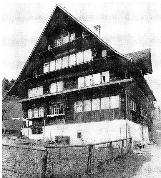
Ebnat-Kappel. Haus im Ganten, erbaut 1687 von der Familie Federli. «Gewappnete» Front mit grosser Firstkammer. – Foto B. Anderes, Rapperswil.
