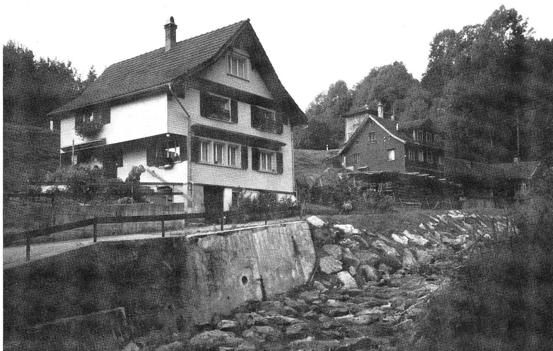
Geburtshaus Bernhard Greuters und ehemalige Mühle, später Sägerei, in Uelisbach bei Wattwil. Heutiger Zustand. – Foto B. Anderes, Rapperswil.
