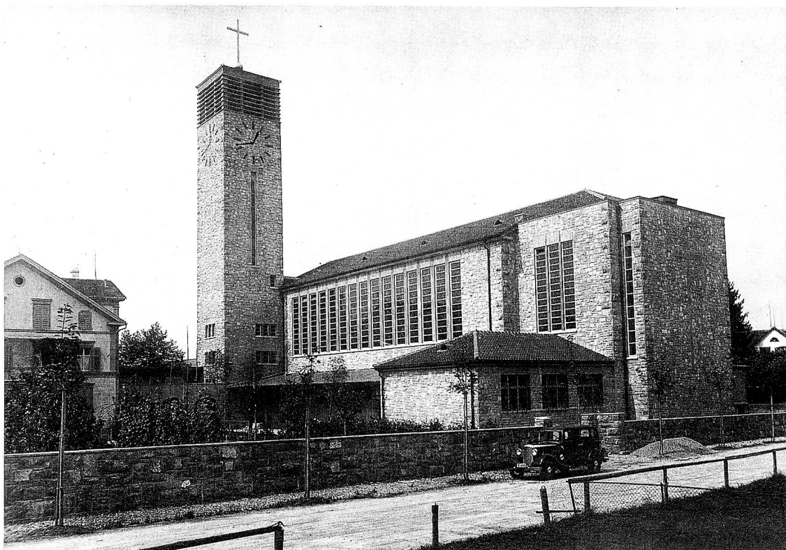
Niederuzwil. Christkönigskirche, erbaut 1933/34 von Karl Zöllig. Hausteinverkleidung über Betonkern. Links Industriellenvilla, um 1870, als Pfarrhaus übernommen. – Foto Karl Zöllig, um 1935.
