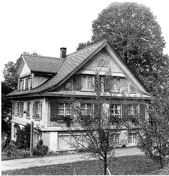
Hemberg. Reformiertes Schulhaus Bächli, erbaut 1838, aufgehoben 1974. Zustand 1994. – Foto B. Anderes, Rapperswil.
