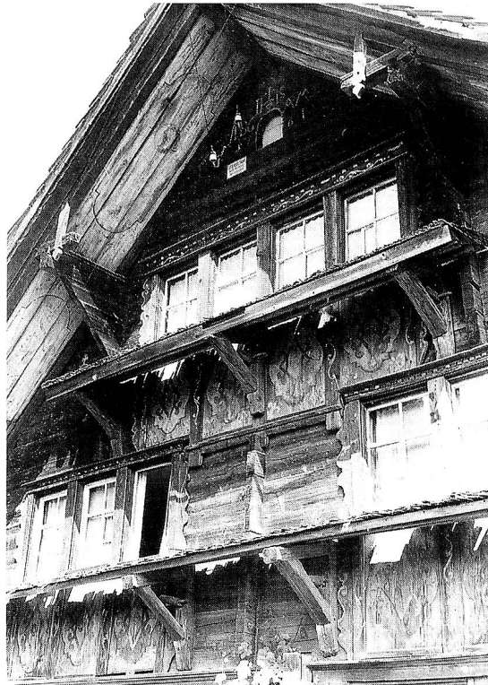
Giebelpartie des Hauses Strässle in Bazenhaid (Nähe Bahnhof) mit offenen Klebedächlein und bemalten Zugläden. Zustand um 1970. Im Giebel Initialen und Datum: IBM AML 1761. Vordachbemalung mit Tufertschwil vergleichbar. – Foto Walter Fietz, St. Gallen.
