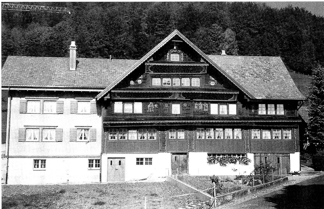
Das «alte Rathaus» in Tufertschwil nach der Restaurierung 1994/95. – Foto B. Anderes.
