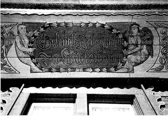
Segensspruch mit Engeln an der Kehle des untersten Klebedachs nach der Restaurierung 1994. – Foto Pierre Hatz, St.Gallen.
