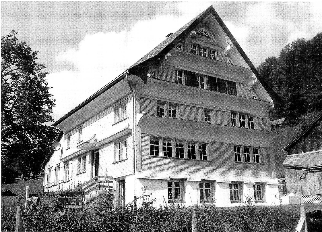
Krummenau, Ober Egg, Haus Nr. 77 nach Restaurierung 1996.
