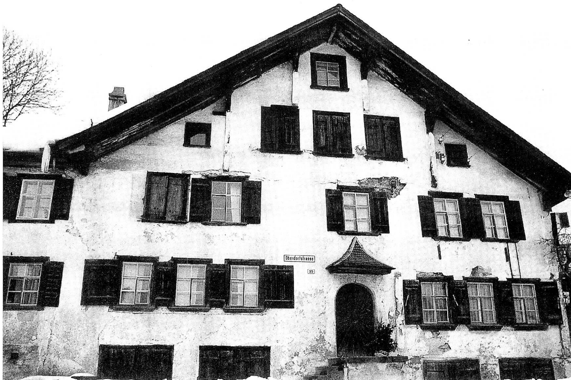
Ebnat-Kappel, Ackerbusweg 26 (ehemals Oberdorfstrasse 35). Giebelfront mit einheitlichem Putzkleid des 19. Jahrhunderts. Die «springenden» Fenster und Unebenheiten lassen die bewegte Baugeschichte erahnen. – Foto Heini Oberli, Wattwil.
