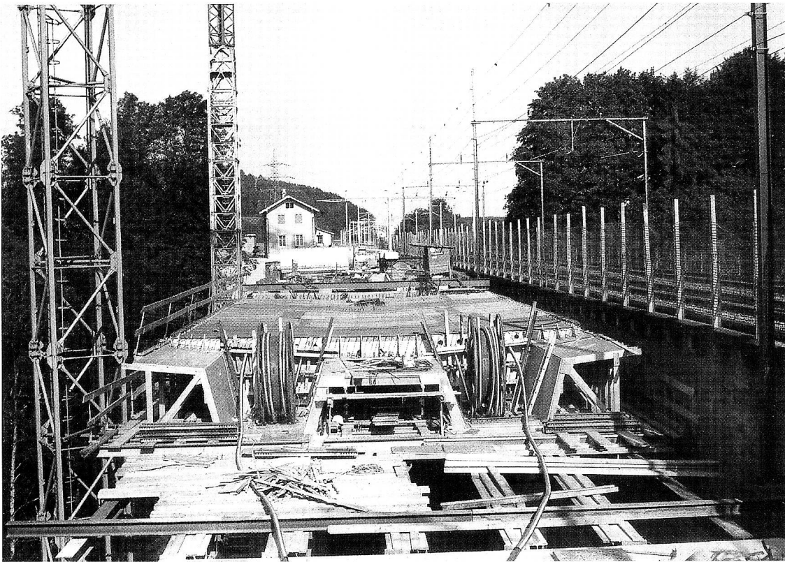
Während einiger Monate wird der Eisenbahnverkehr einspurig über das neue Viadukt in provisorischer Lage geführt. Nach dem Abbruch der Betonbrücke von 1927 und dem Bau der endgültigen Fundamente und Widerlager erfolgt der Vershub des ganzen Bauwerkes. In Zahlen: Das rund 6000 Tonnen schwere Glattviadukt wird in höchstens 9 Stunden um 10,25 Meter querverschoben.
