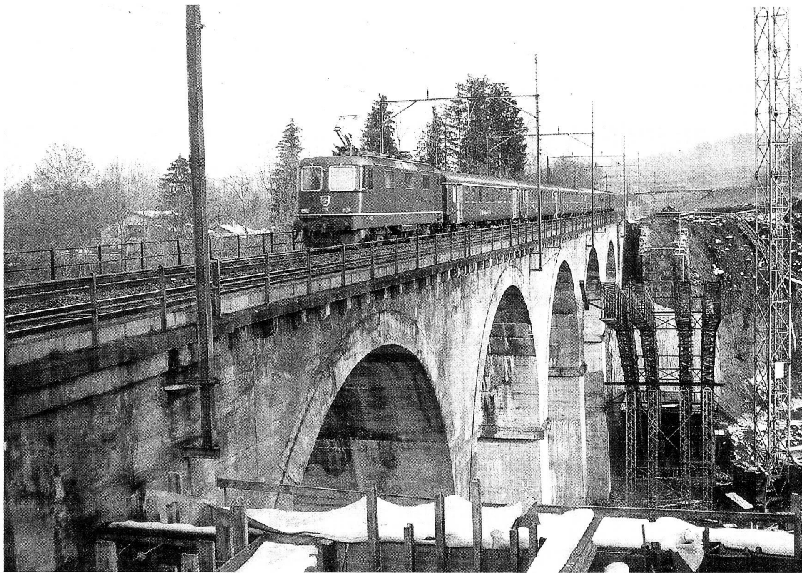
Die mächtigen Gerüstbogen lassen die vorläufige Lage des neuen Glattviadukts erkennen. Der Neubau erfolgt also im Bereich der einstigen St.Kolumbansbrücke.
