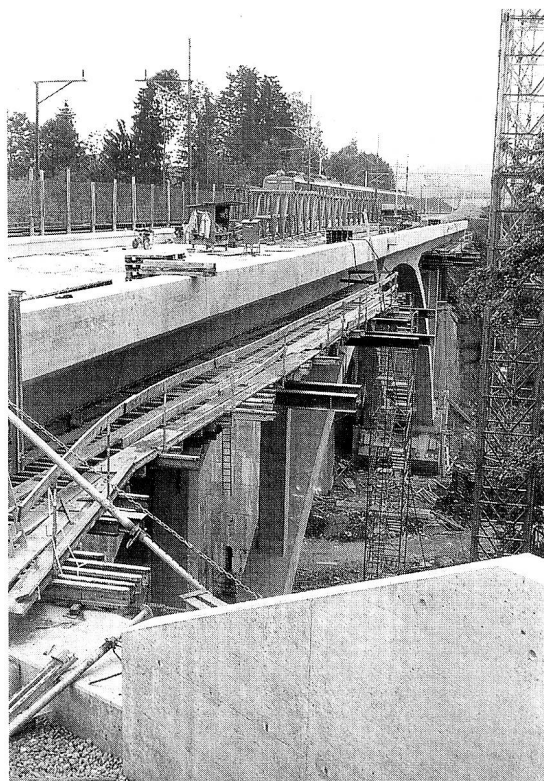
Das Bauwerk präsentiert sich, Ende September weitgehend von Schalung und Gerüst befreit. Auf beiden Talseiten Vorbereitungen für die provisorische Verlegung der Eisenbahnlinie.
