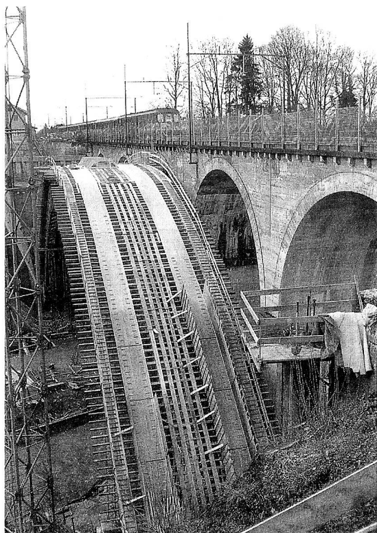
Eindrucklich präsentiert sich der Brückenbogen mit einer Spannweite von 82 Metern im März 1996 aus einmaliger Perspektive.
