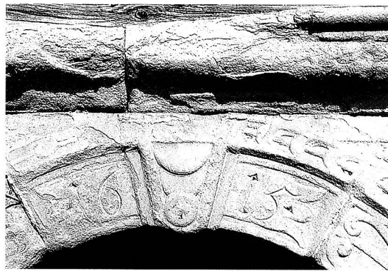
Erkeruntersicht und Sandsteinportal. Scheitel mit Datierung «1615» (Baudatierung) und späteren, etwas unglücklich eingefügten Buchstaben «R», ? und «W». Erkennbar sind auch unterschiedliche Farbspuren in den tiefsten Einschnitten der Reliefs.
