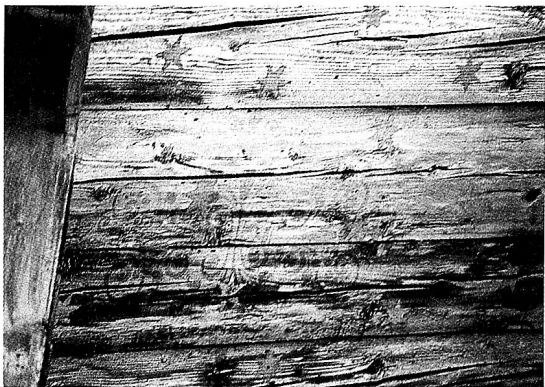
Nordostfassade mit Schindelschirm, anschliessend die verbretterte Stirnseite des angebauten Schopfs. Hinter dem Schindelschirm im Erd- und Obergeschoss ein rot-weiss gefasster Sichtriegel, darüber eine rot gestrichene Blockwand, das Ganze einst gekrönt von einer Dachuntersicht mit «goldenen» Sternen. Vertäferung und Verschindelung des Turmerkers im Frühjahr 1996 in Anlehnung an die vorherige Machart; leider wurde die ursprüngliche Sichtriegelfassung nicht beachtet. Rechts: Dachuntersicht des Südost-Giebels. Durch die blaue Farbe mit ockerfarbig aufgemalten Sternchen schimmert ein älterer weisser Grund mit schwarzer Schablonmalerei.
