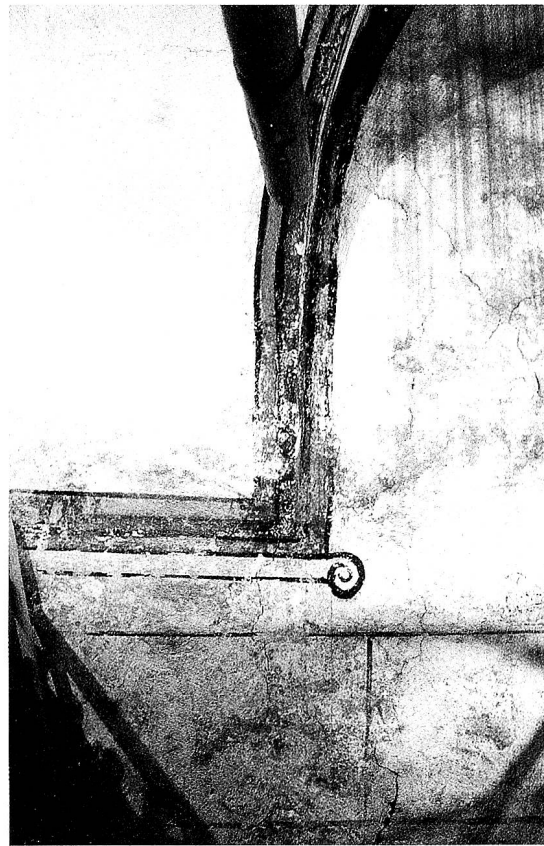
Wandmalereien im Gewölbekeller Nord. Im unteren Wandbereich ist eine Quadriering vorgetäuscht, darüber sind die Gräte des Kreuzgewölbes farbig gefasst.
