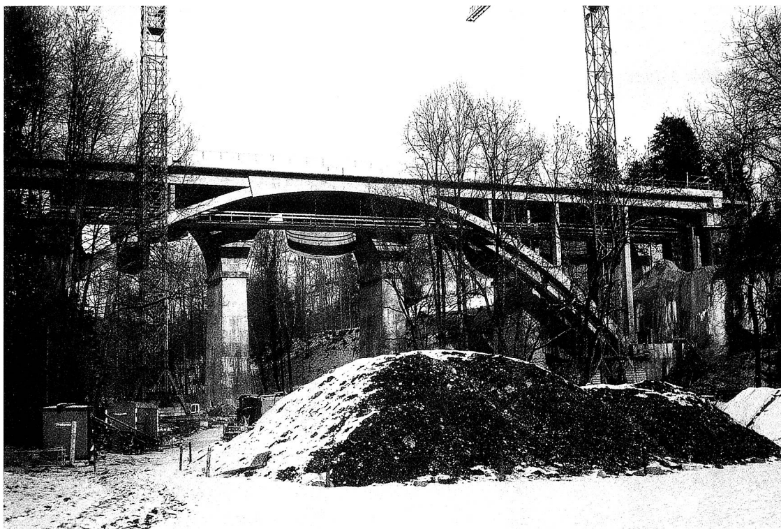
Am Wochenende vor der Sprengung zeigen sich das ausgediente Glattviadukt und die elegante neue Bogenbrücke in der Wintersonne.
