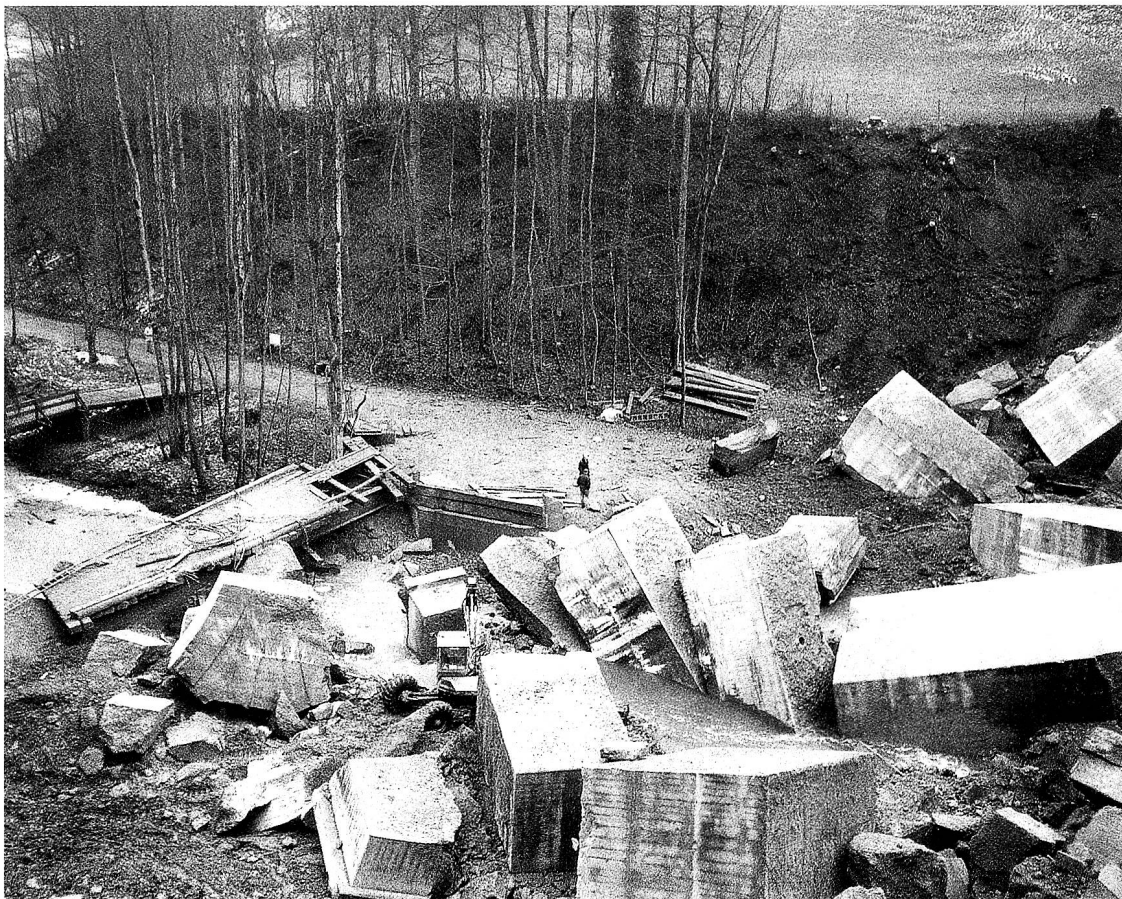
Am Morgen nach der Sprengung: Die Trümmer der Pfeiler liegen teilweise im Bett der Glatt. Die schwere Werkbrücke wurde aus den Widerlagern geworfen und erheblich beschädigt.
