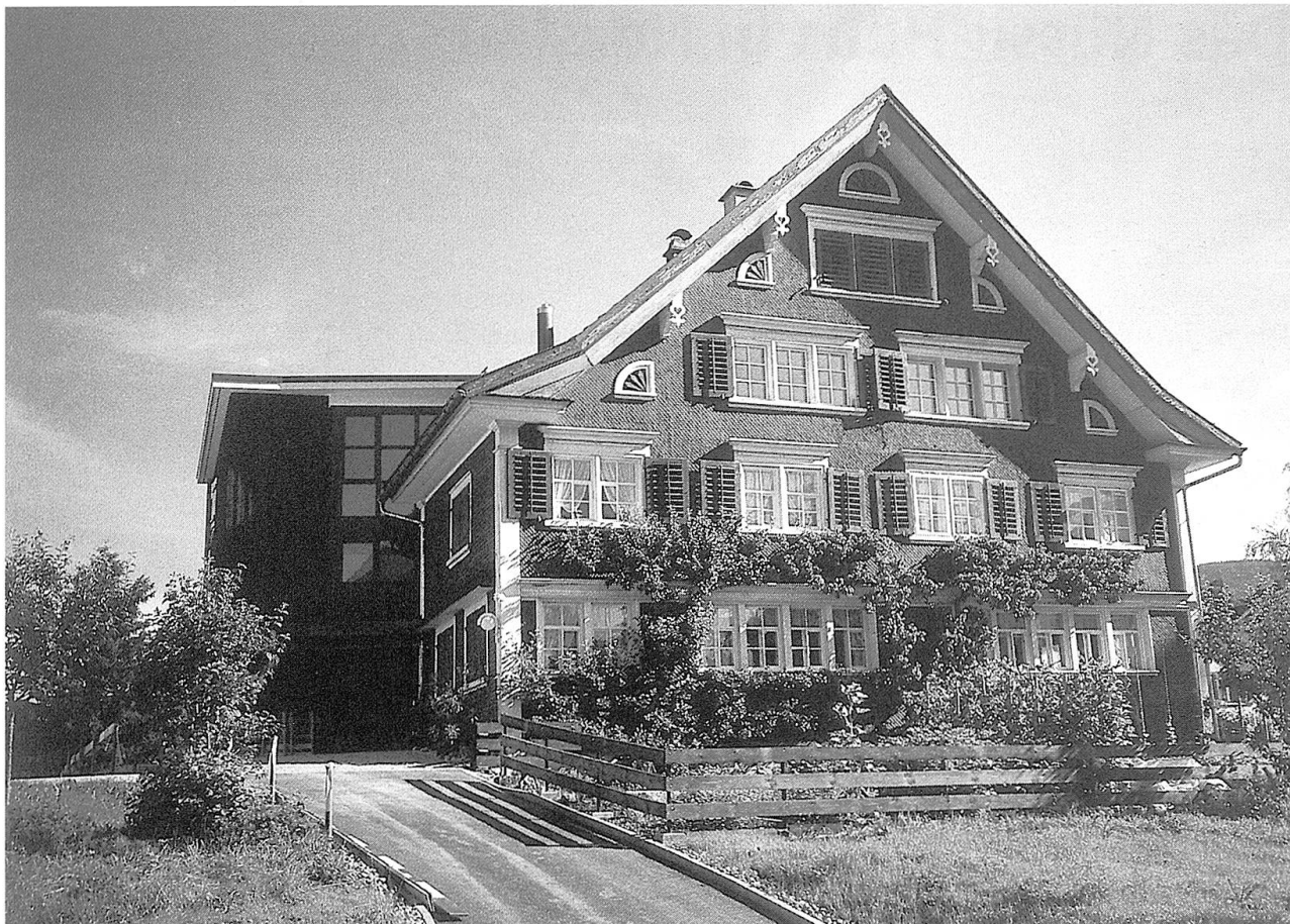
Das Haus Nüssli nach der Gesamtrenovation. An der Stelle eines ehemaligen Schopfes liess sich in einem schlichten Anbau eine neue Erschliessung verwirklichen.
