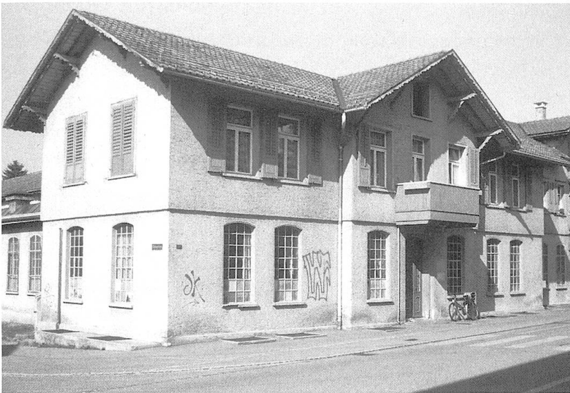
Die Schürzenfabrik Stutz Weiss GmbH an der Oberdorfstrasse 29. Ursprünglich als Stickfabrik errichtet. Ab 1919 bis Ende der 40er Jahre Sitz der Strumpffabrik Vereina.
