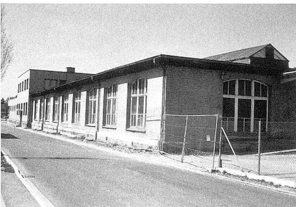
Gebäude der heutigen Frey & Co. AG, Burgauerstrasse.
