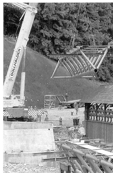
Einbau der Stahlträger.
