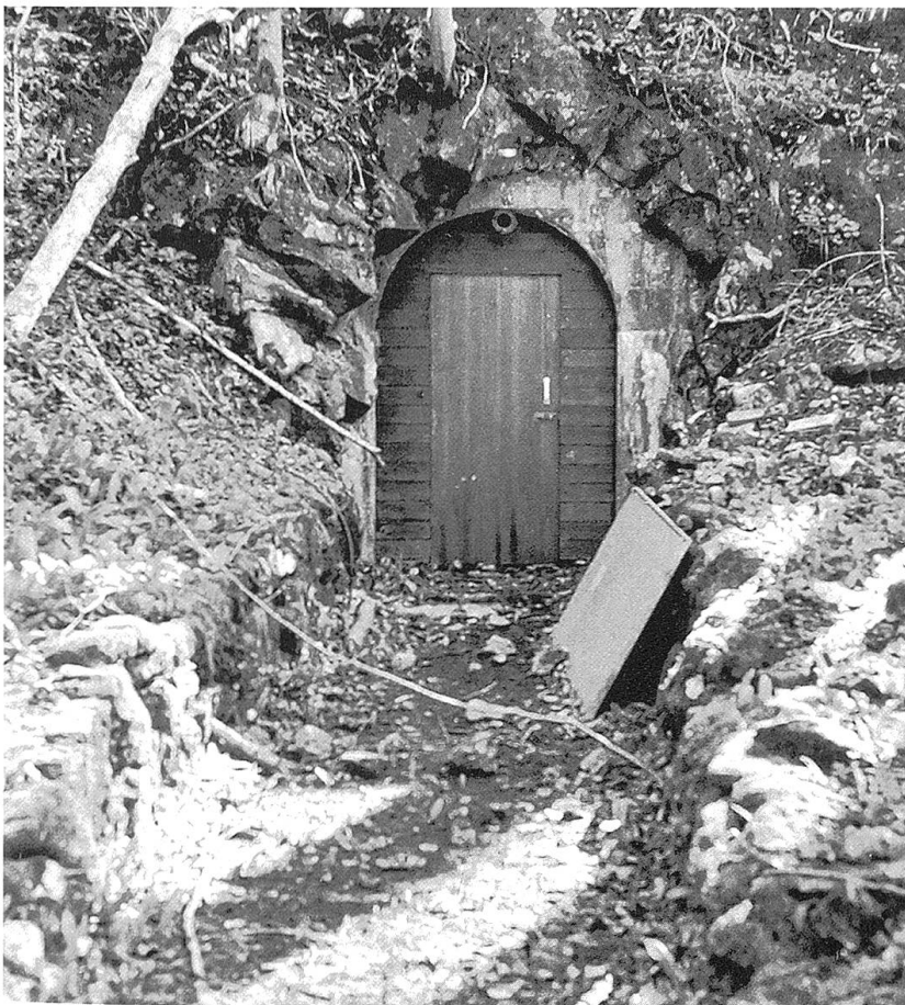
Eingang «Starkenbach Nord». Vorgehängte Holzarttür, darüber Auspuffstutzen. Seitwärts, liegend, die schon demontierte Gasschleuse. Aufnahme Mai 1999.
