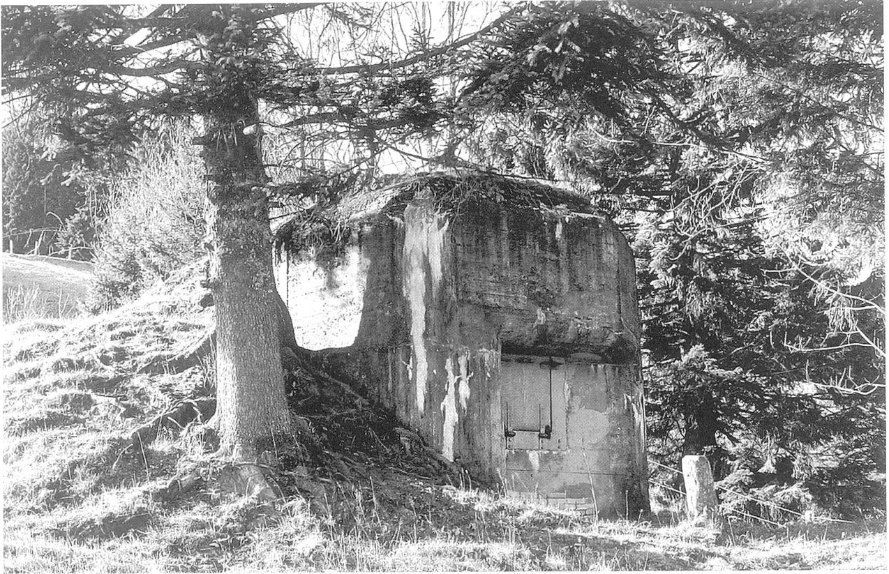
Das in den Hang hinein gebaute Werk «Grossrüti». Aufnahme November 2002.
