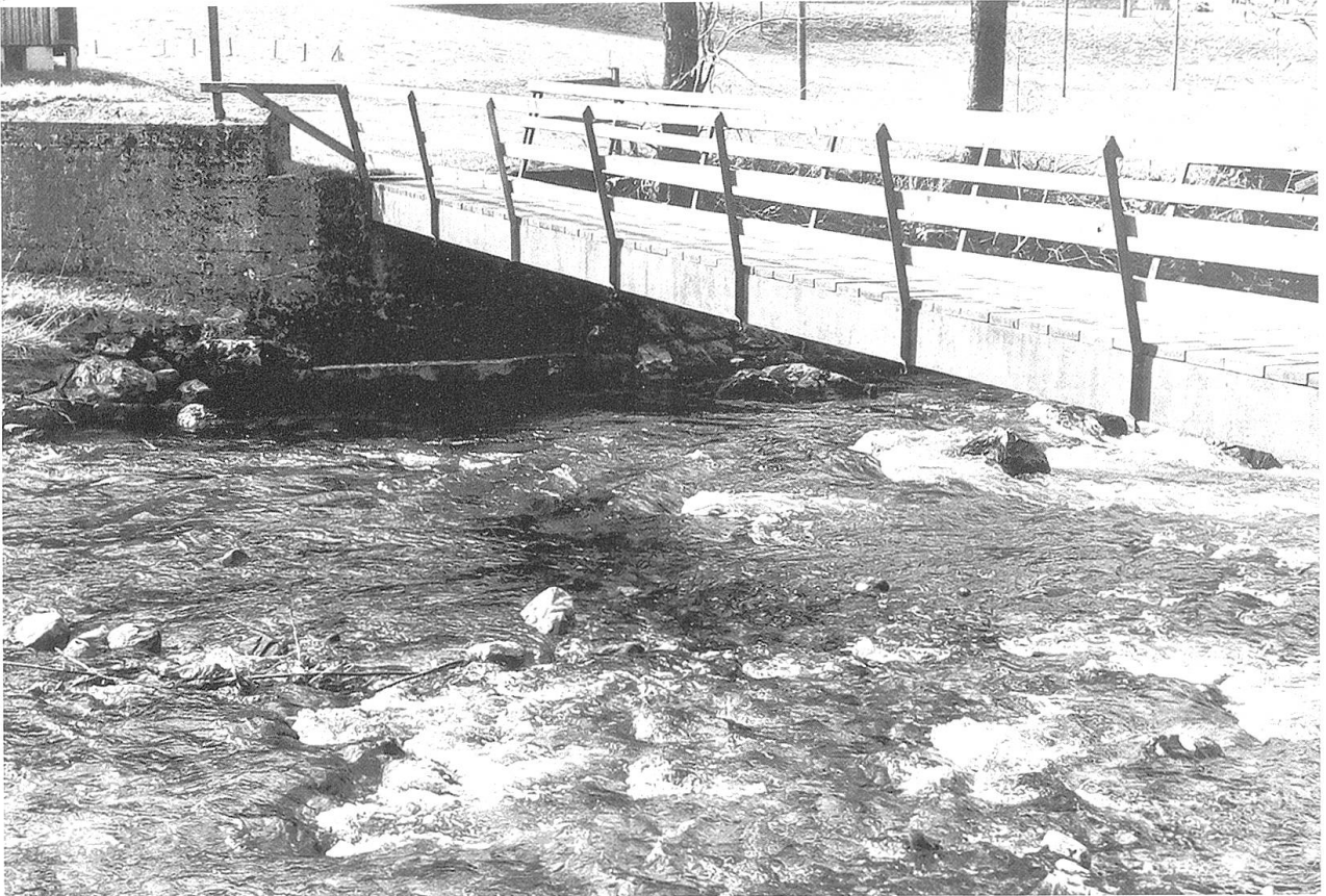
Ende der Tankmauer bei der Thur. Fortsetzung in der als Hindernis absenkbaaren Stahlbrücke. Aufnahme November 2002.
