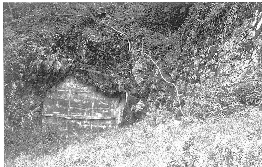
Mg-Scharte links in mit Naturstein verkleideter Böschung. Aufnahme August 2002.
