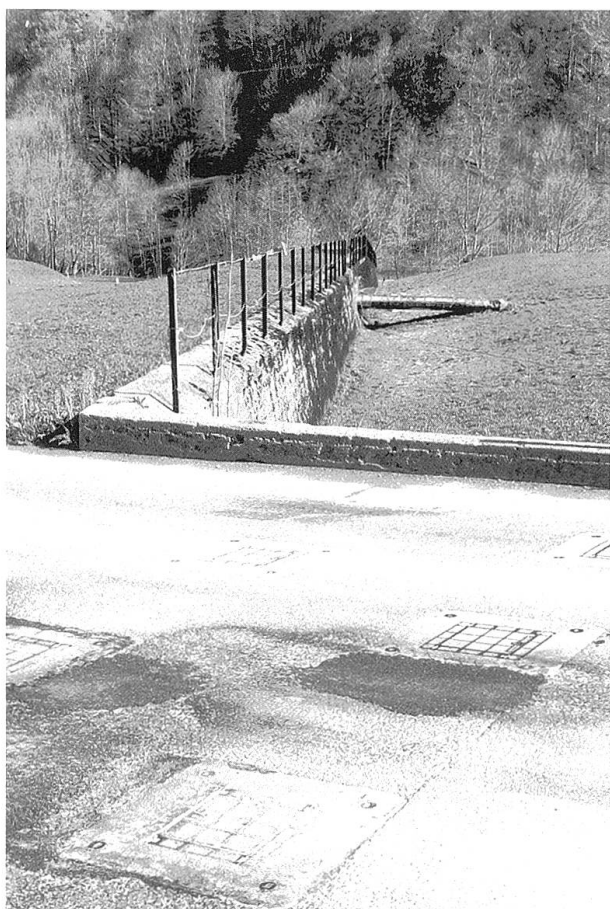
Schächte der Strassen-Tankbarrikade. Fortsetzung als Tankmauer gegen Norden. Aufnahme Mai 1999.
