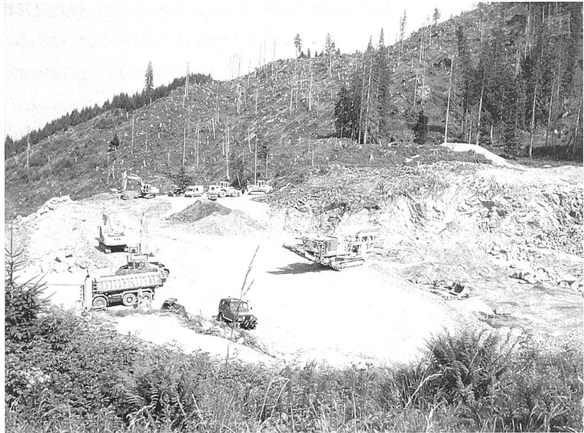
Bau des 50 Meter breiten Dammfusses (Juli).
