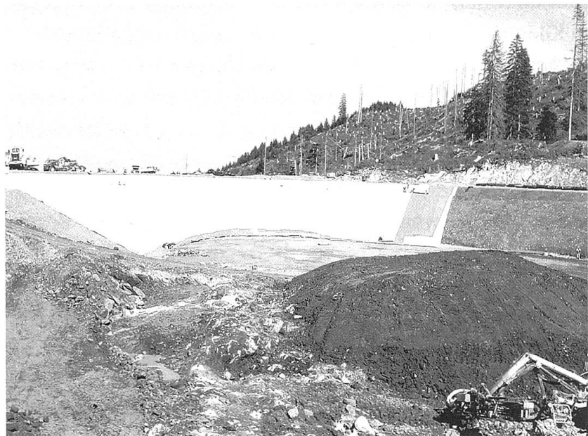
Die Abdichtfolie wird eingelegt (September).
