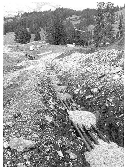
Wildhaus: 1,5 Kilometer Leitungsgräben mit über 10 Kilometer Leitungen.
