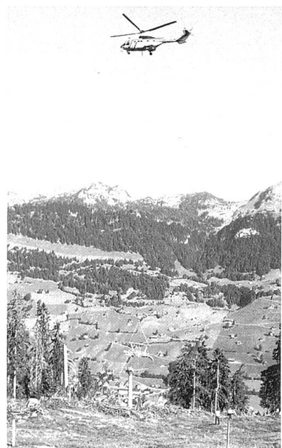
Alt St. Johann: Montage der Masten und der Rollenbatterien im Herbst 2003 durch einen Superpuma-HB-XVY.
