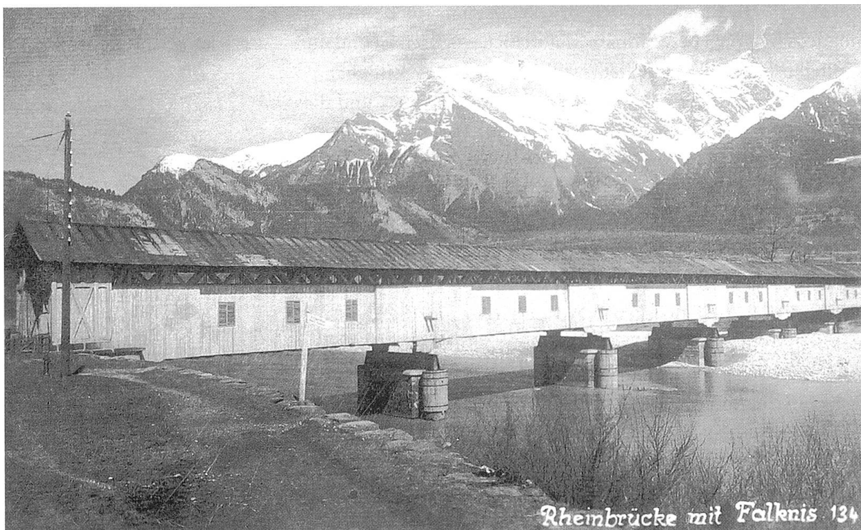
Die Eisenbahnbrücke (Bauart Howe) von Ragaz um 1920. Sammlung A. Heer.
