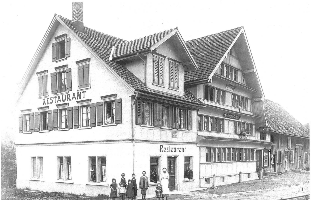
Die «Mühle» nach dem Umbau 1907–1909.
