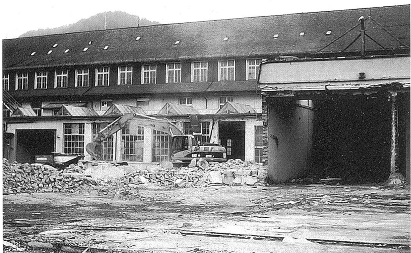
Die Abbrucharbeiten auf dem Heberlein-Areal sind angelaufen.
