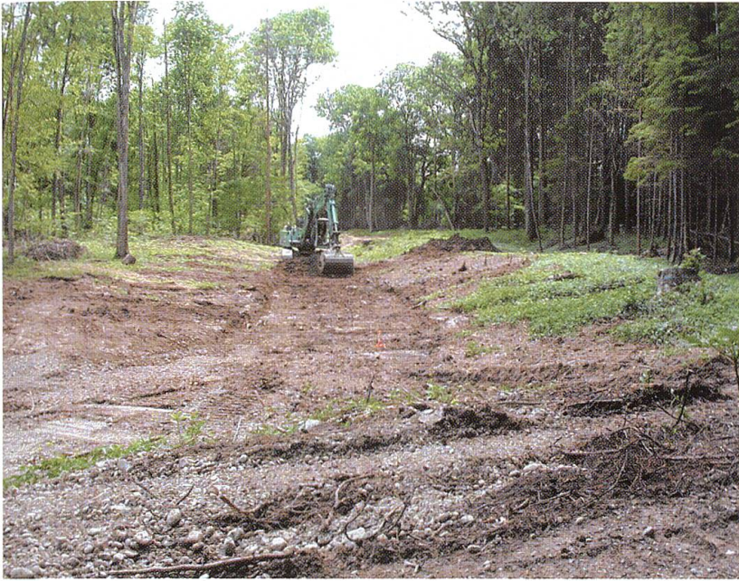
14. Juni 2005, Bau Gerinne entlang trockengelegten Altläufen (Abb. 13).
