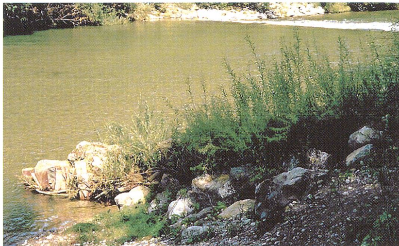
Buhne als Ufersicherung und zur Lenkung der Strömung, Bereich Sportplatz Niederstetten (Abb. 11).
