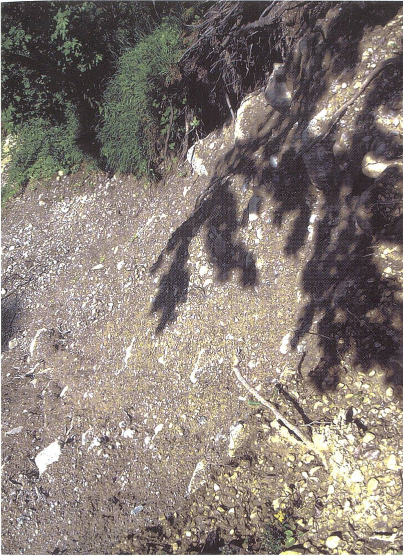
Mittleres Steintal, Weissbad-stadialer Moränenwall bei Allmen. Der Geissbach (links ausserhalb) hat infolge seiner Seitenerosion einen Anriss hervorgerufen. Das Lockermaterial ist typisch für eine Wallmoräne: grobe, kantige Blöcke wirt eingelagert in sandiger bis lehmiger Grundmasse grauer Färbung. Hier liegt die Moräne zerrüttetem, bräunlichem Nagelfluhfels auf (rechts unten). Foto: O. Keller.
