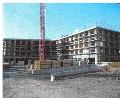
Klinikneubau Sonnenhof, Ganterschwil.
