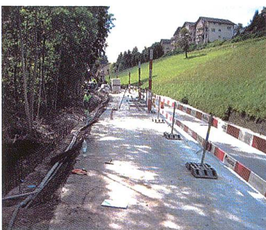
Sanierung der Strasse nach Herisau.
