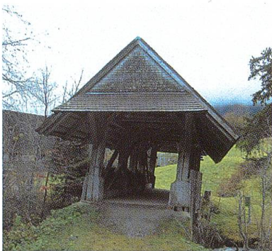
Holzbrücke über die Wiss-Thur.
