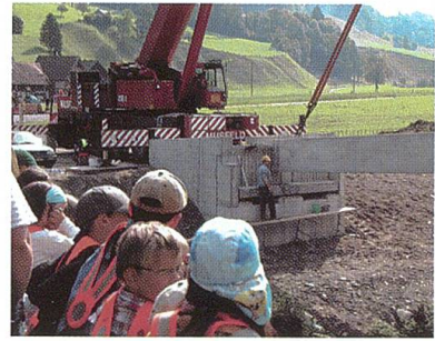
Bau der Brücke über den Necker.
