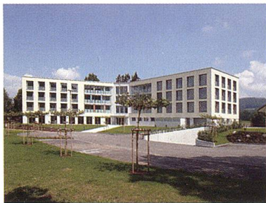
Das neue Klinikgebäude.
