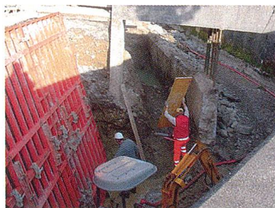
Bauarbeiten des Hochwasser- schutzprojekts.
