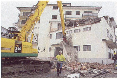
Abbruch des «Mühlehofs».
