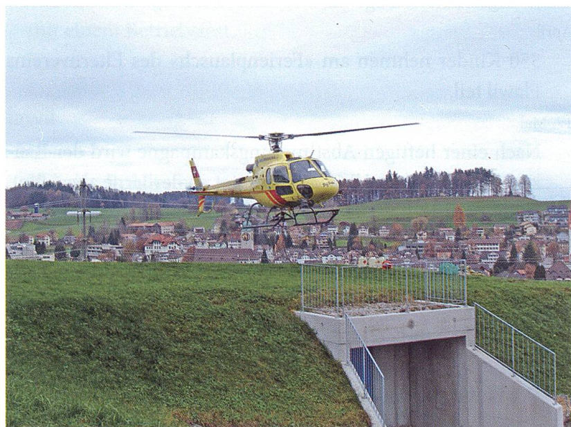
Verlegung der Hochspannungsleitung Fuchsacker.
