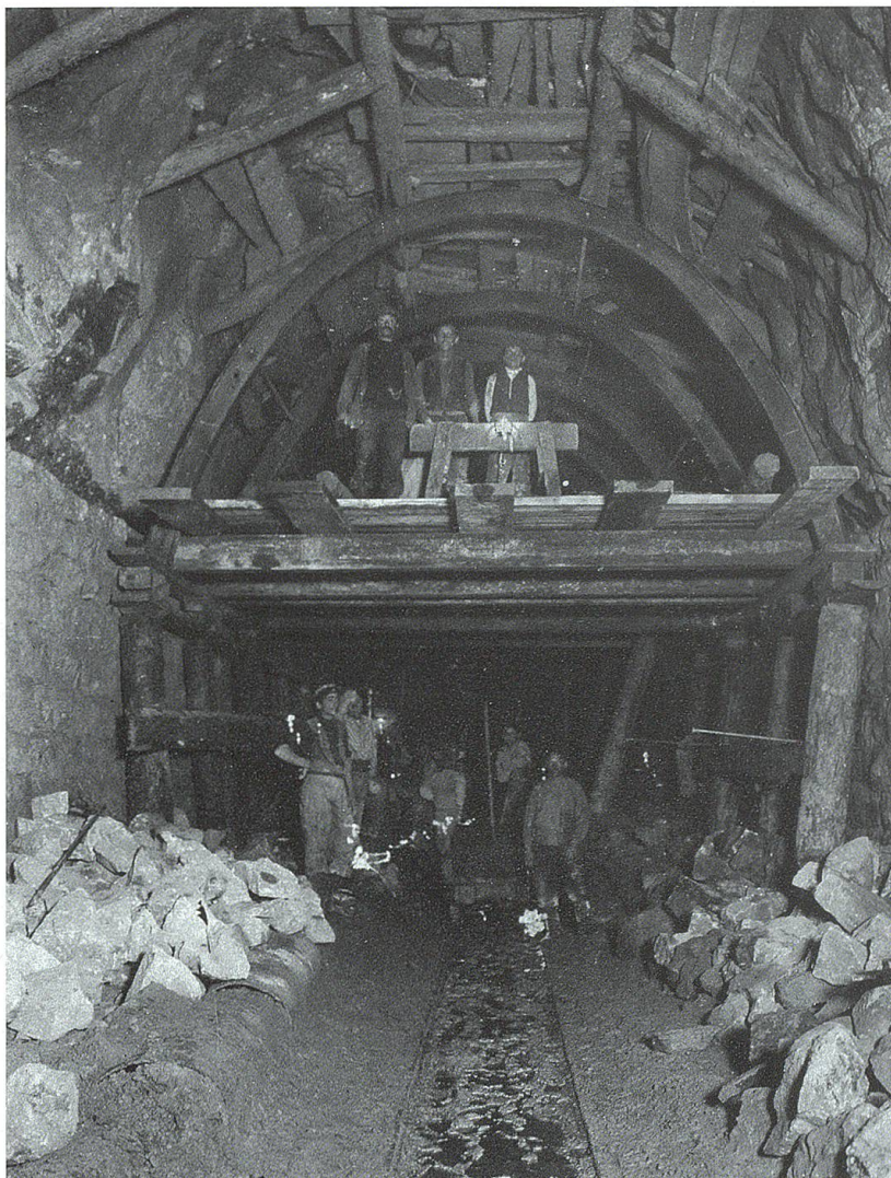
Gewölbebau im Rickentunnel. Foto: Sammlung TML.
