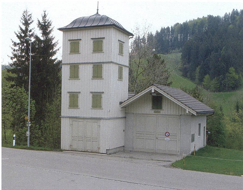
Das Spritzenhaus der Dickler Feuerwehr mit dem Tröckneturm für die Schläuche und Seile. Foto: Privatbesitz.
