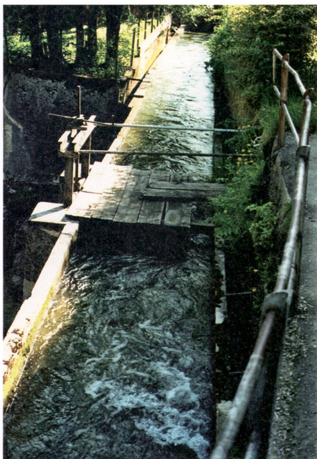
Bild links: Wehr im Bereich der Herrenmühle mit Einlaufbauwerk zum Oberwasserkanal der Fabrik Meyer-Mayor. Das Unterwasser der Herrenmühle wird in diesen Oberwasserkanal eingeleitet. Bild rechts: Oberwasserkanal mit Überlaufschieber.
