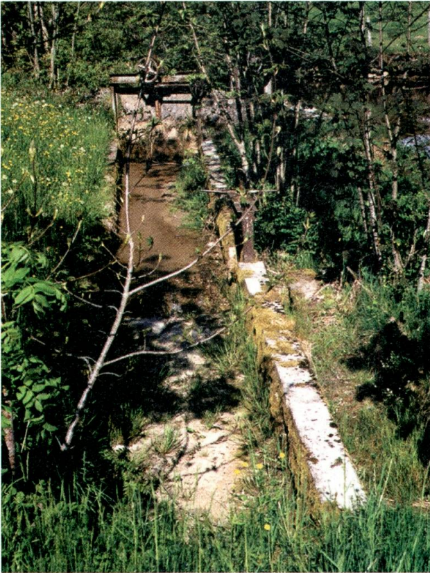
Bild links: Wehr und Einlaufbauwerk Herrenmühle mit Oberwasserkanal und Überlauffalle. Bild rechts: Herrenmühle mit dem westlichen Teil, in dem sich früher die Mühlenanlage mit separatem Wasserrad befand. In der Mitte der Auslauf des Unterwassers in den Oberwasserkanal der Anlage Meyer-Mayor. Letzterer und der einstigen Ausäuge dient auch das Wehr mit Einlaufbauwerk, damit diese auch betrieben werden können, wenn die Herrenmühle ausser Funktion ist.
