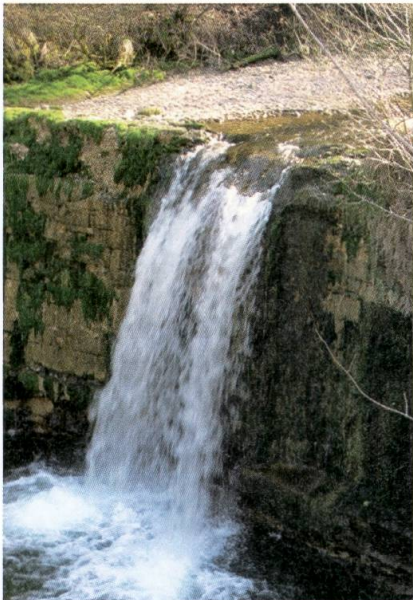
Bestehende Staumauer mit Wasserfall und Fabrikgebäude im Hammertobel.
