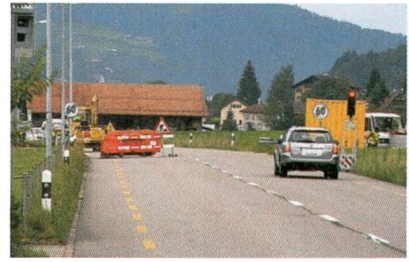
Die Brücke über den Gerenbach wird ersetzt.
