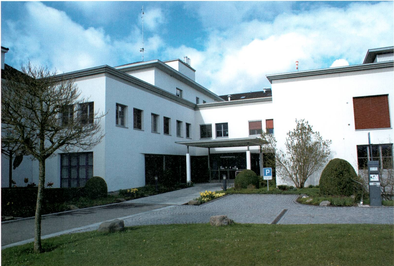
Eingang zum kantonalen Spital Flawil. Foto: Anton Heer.
