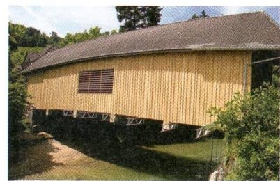
Die renovierte Tös-Brücke über den Necker.
