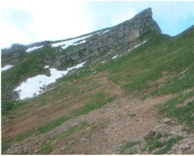
Rüfen verschütten den Speerweg.
