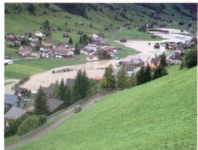
Erste Bewährungsprobe für die Thurverlegung.
