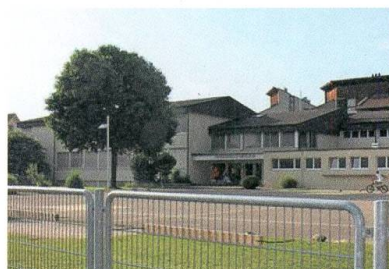
Das sanierungsbedürftige Primarschulhaus Schwarzenbach.
